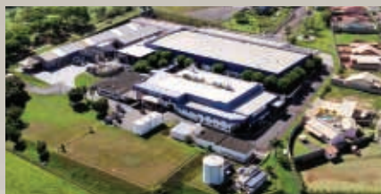
Jaguariúna - SP: Climatização e Arrefecimento
